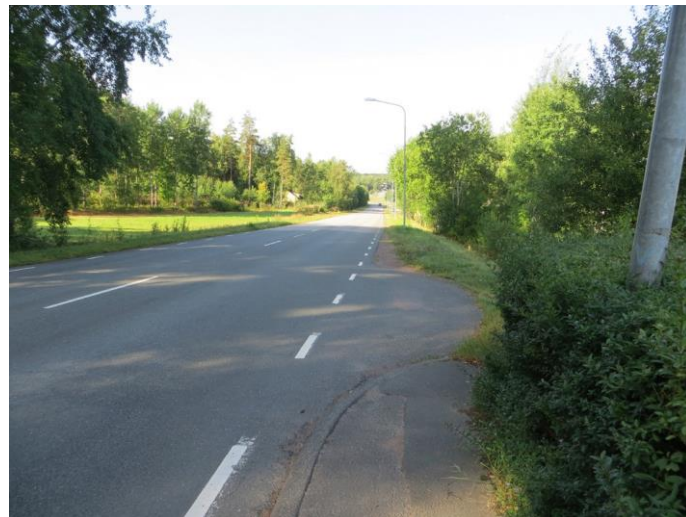
1. Trottoar och cykelbana uppbör på Jönköpingsvägen
