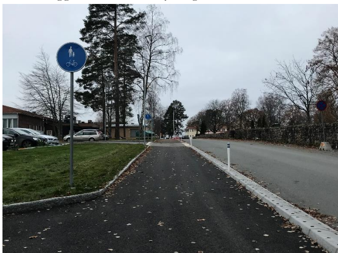
8. Gång- och cykelväg på Jularpsvägen. God skyltning och belysning.
