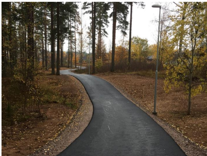
12. Gång- och cykelväg i Vittaryd, norr om Parkskolan. Vägen är i mycket gott skick, belyst och skyltad.
