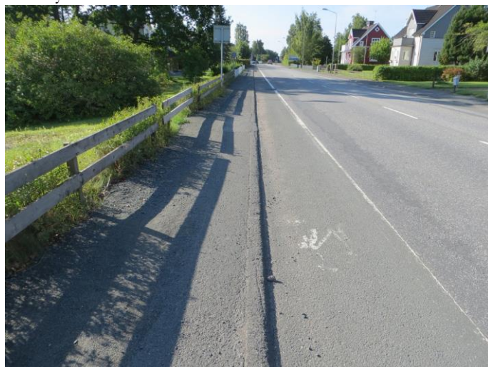
2. Trottoar och en otydlig cykelbana på Grännavägen
