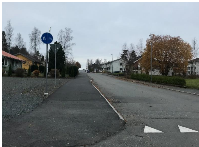
7. Nyanlagd gång- och cykelväg. Skogsgatan.
